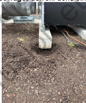
Longrines béton sur plots plastique.
